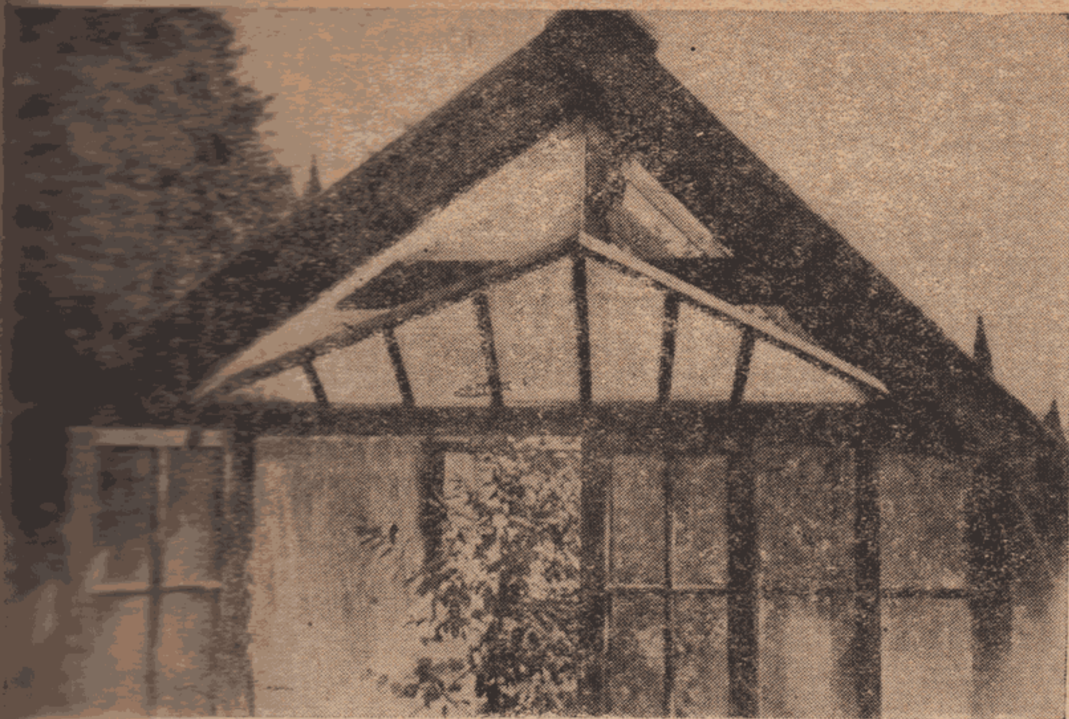
Рис. 7. Боковая вентиляция гелиоранжереи через подъемную раму у конька
