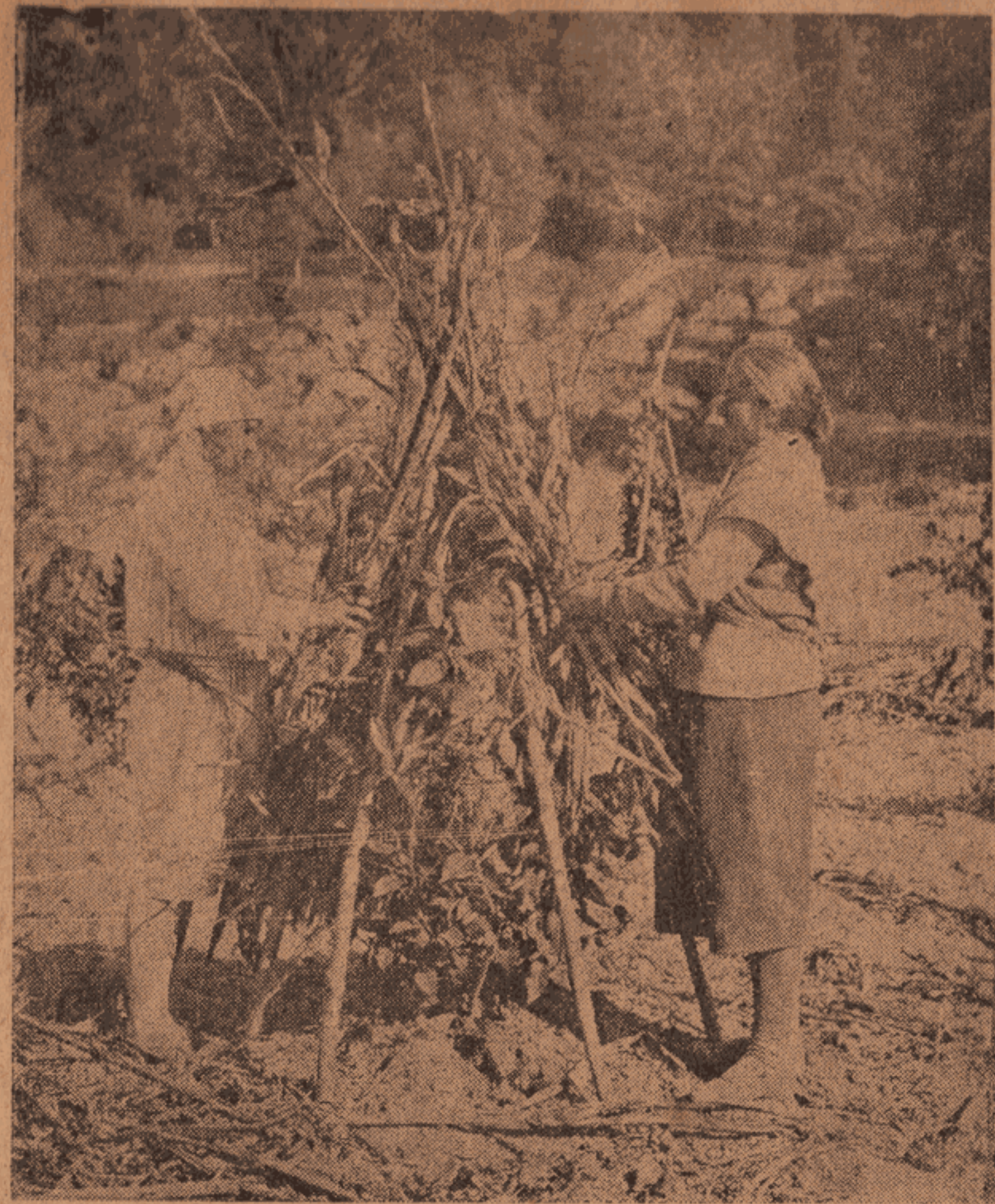
Рис. 16. Обкладывание чала вокруг каркаса.
